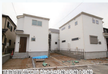
建物外観(施工中) (左から2号棟・3号棟・1号棟)
